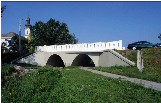
1. ábra: A solti vasbeton boltozatú csatorna híd
