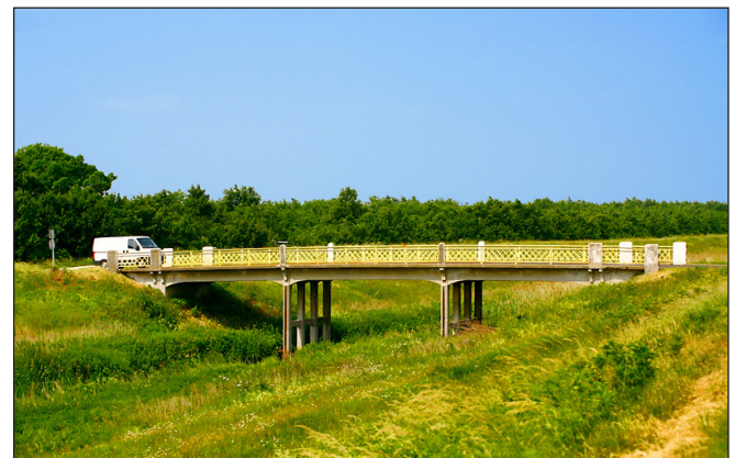
4. ábra: Rábakecöl Répce-árapasztócsatorna hídja
