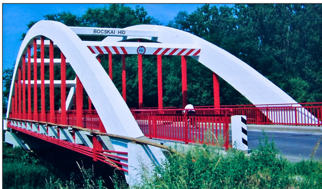
10. ábra: A tiszalöki Keleti-főcsatorna-híd
