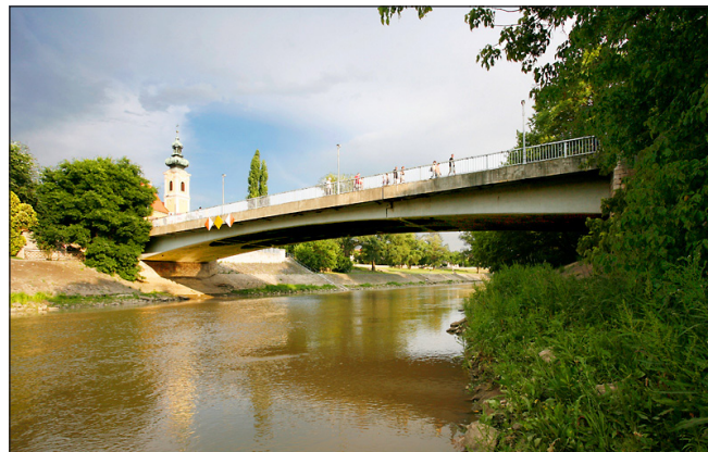
7. ábra: A győri Sétatéri Rába-híd
